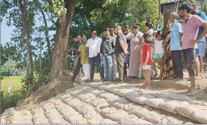
■ বাঁধ তৈরির কাজ পরিদর্শনে সেচ আধিকারিকদের সঙ্গে সুমন কাঞ্জিলাল।
