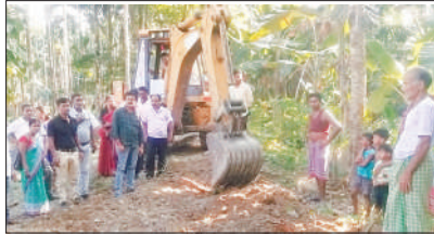
■ রাস্তার কাজ পরিদর্শনে সুমন কাঞ্জিলাল।
