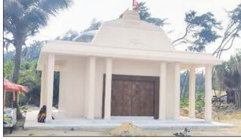
■ দিঘায় নবনির্মিত জগন্নাথদেবের মাসির বাড়ি।
